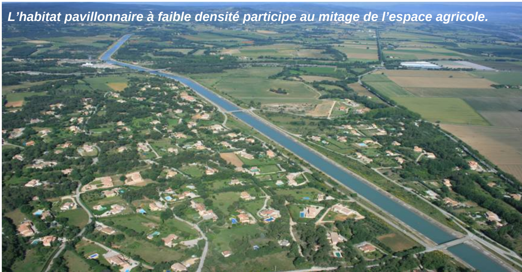
Vue aérienne Pays d'Aix – chambre d'Agriculture des Bouches-du-Rhône
