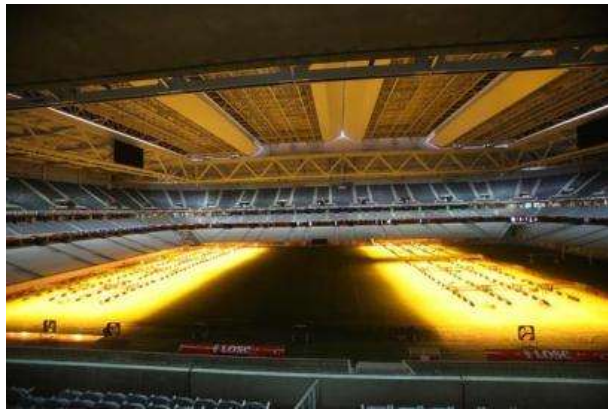
Exemple de positionnement des rampes d'éclairage
